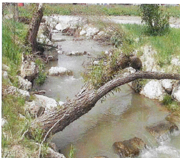
Slika 4: Prikaz sonaravno urejenih strug z motilnimi kamni in delnimi pragovi.
